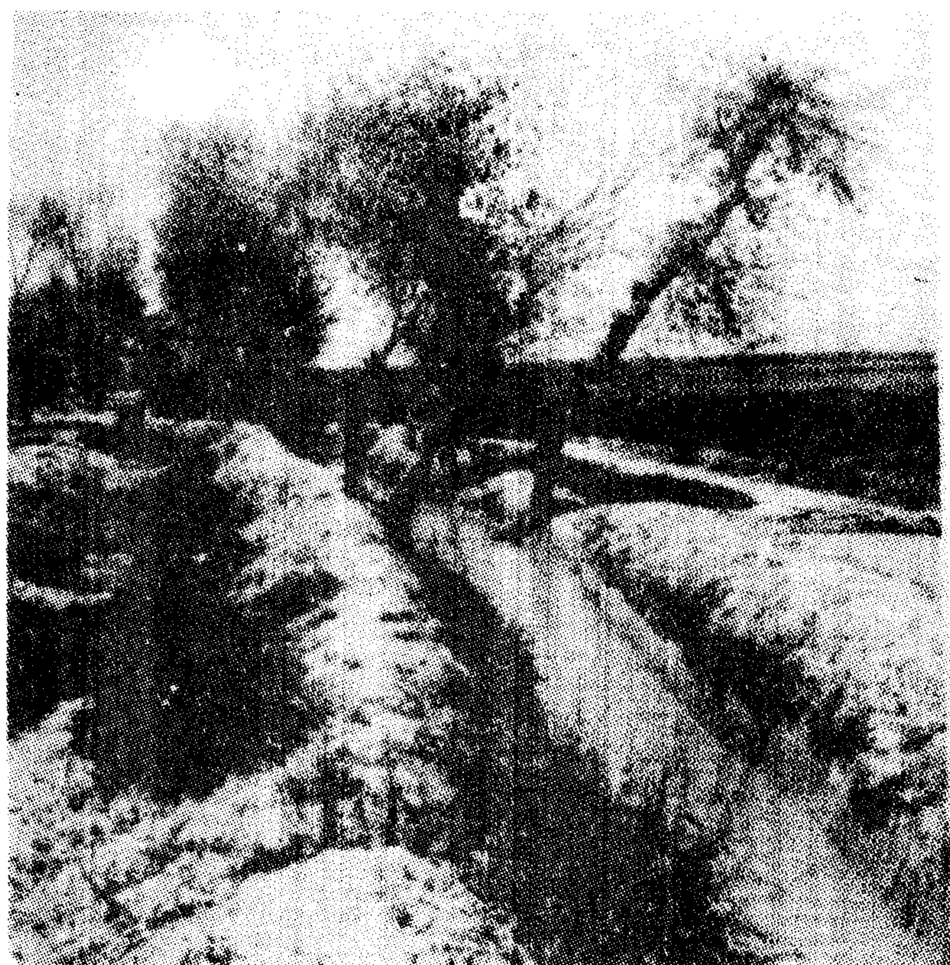
شکل ۲- رویش درختان در کناره کانال باعث تلفات تبخیر گردیده و ریشه درختان باعث ایجاد حفره ها و سوراخهای زیادی در کناره کانال می گردد. (روستای هلهوله شمال اهواز)
